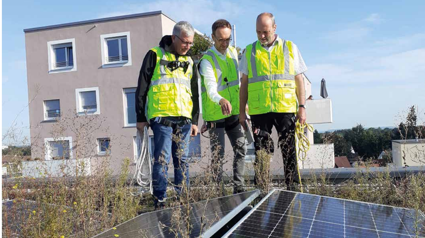
Die Photovoltaik-Anlagen im Fürther Westwinkel müssen regelmäßig inspiziert werden.
